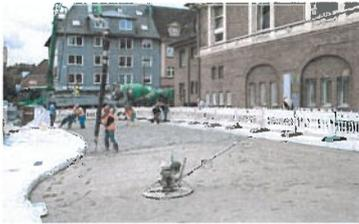
Der neue barrierefreie Busbahnhof im Norden von Dortmund wurde mit umweltaktiven Fahrspuren ausgestattet. Sie bestehen aus einem Beton, der mit dem photokatalytisch wirksamen Zement „TioCem“ von Heidelberg-Cement produziert wurde.
