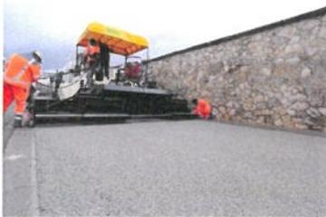
Wenn Regenwasser nicht schnell genug von der Fahrbahnoberfläche abfließt, entsteht gefährliches Aquaplaning. Dies lässt sich durch den Einsatz von wasserdurchlässigen Fahrbahnbefestigungen aus Beton – dem sogenannten Dränbeton – effektiv vermeiden.
