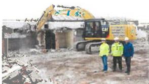
Caterpillar hat seinen Hybridbagger 336F XE weiterentwickelt. Was ursprünglich für den Erdbau vorgesehen war, bewährt sich inzwischen auch in anderen Einsätzen. So arbeitet das Unternehmen Libare aus Winterlingen im Rückbau und Recycling mit drei Hybridbaggern, einem 336E H und zwei 336F XE.
